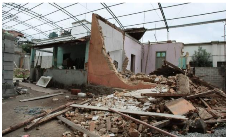
Foto 9 - Imagem retirada da notícia - Casa demolida
